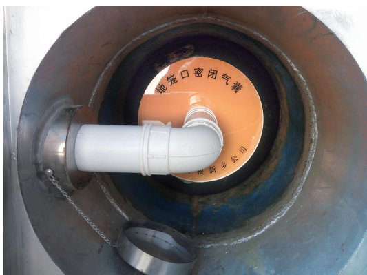
地笼口密闭隔热气囊使用图
