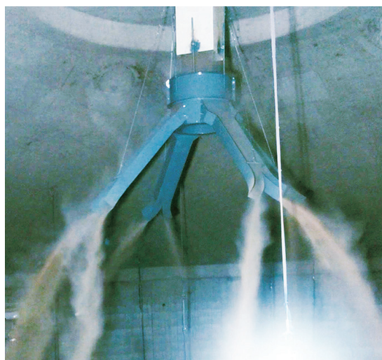
浅圆仓“器”字型防破碎无动力匀料入仓布料器
