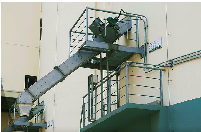
侧壁发放抑尘斗安装效果图
